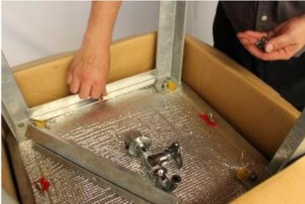
脚4本をボルトで取付けてから、赤印ボルトに、断熱材押えアングルの、赤印孔を挿し通して、平座金・ばね座金を順次通し置いて、アングルが曲がらない程度に、ナット締めして下さい。
